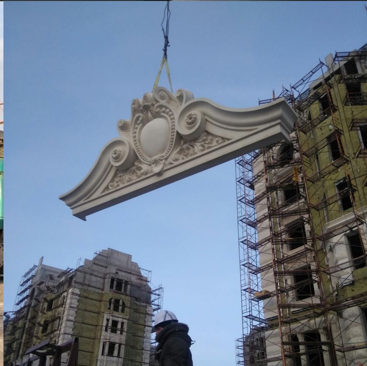
Проектирование, производство фасада, доставка и монтаж ЖК "BAISANAT" г. Астана Стеклофибробетон GFRC.
